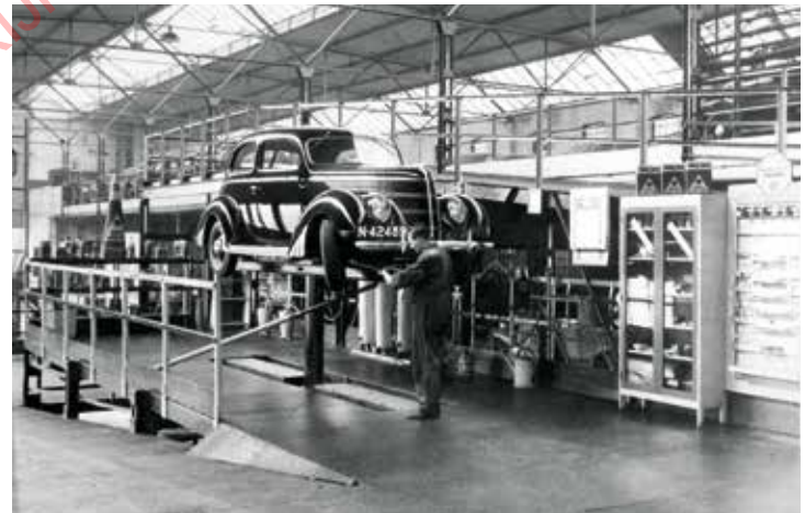
Een deel van de stallingsgarage is in gebruik als werkplaats. Hier staat op de hefbrug de Ford 1938 van Van Gaal uit Helmond.
